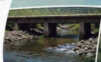
OBRAS HIDRÁULICAS PUENTES, DRENAJES, ENCAUZAMIENTOS Y PROTECCIÓN DE CAUCES
